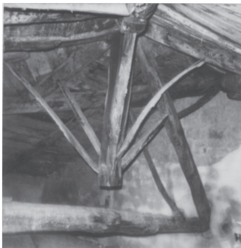
Carpineto: monaco al centro della capriata (antica struttura in legno del soffitto a capriata).
